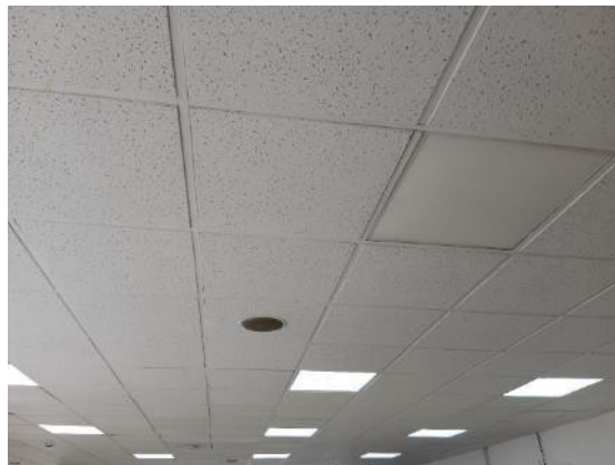
Techos y sistemas de iluminación
