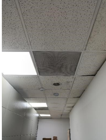
Registro fotográfico 3. Rejillas y lámparas
